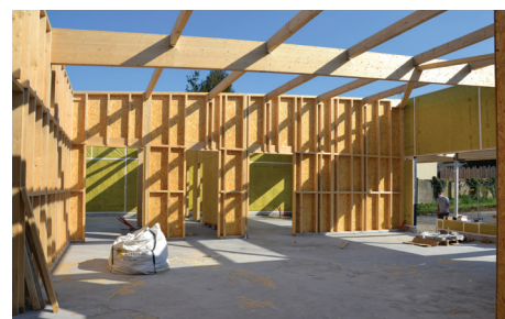
Poursuite des travaux
