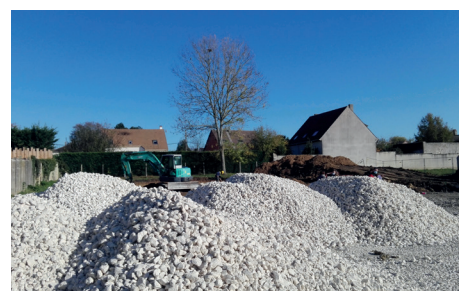
Démarrage des travaux de la future école
